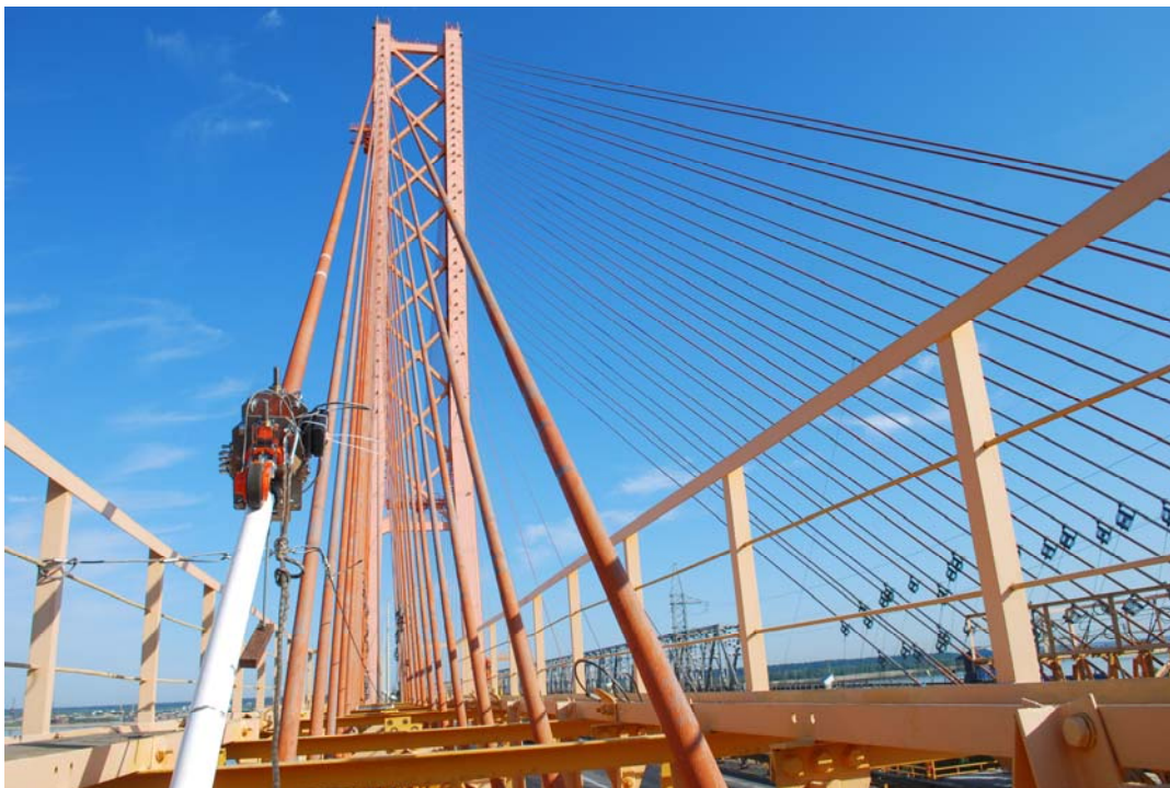
Рисунок 6 - Завершение контроля каната мостового сооружения
