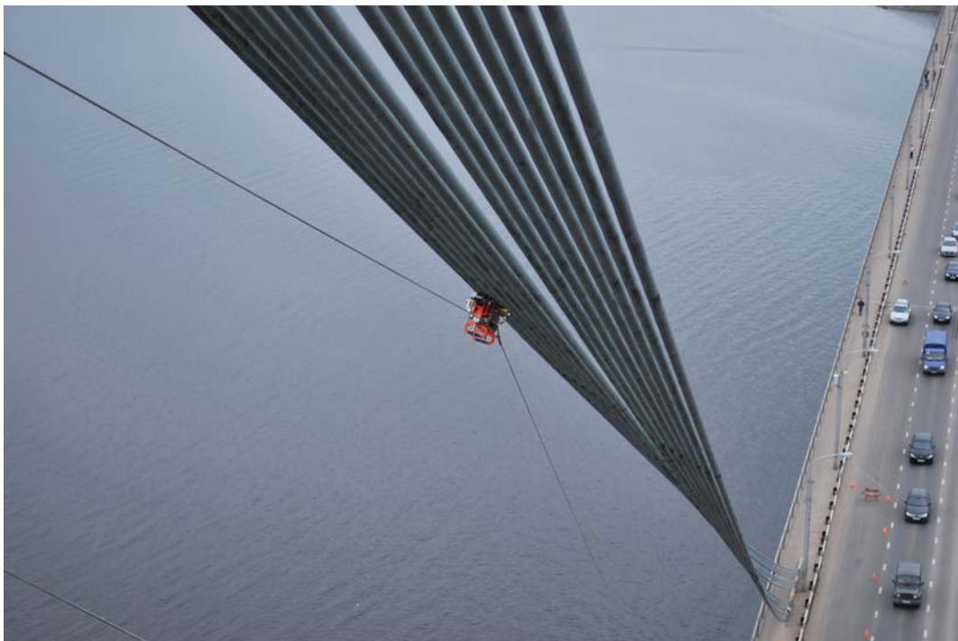
Рисунок 5 - Контроль каната мостового сооружения при спуске дефектоскопа
