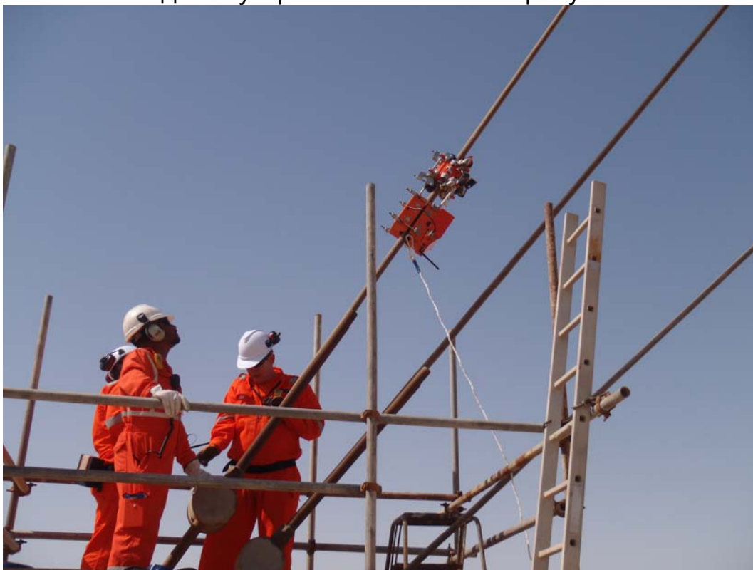
Рисунок 1- Контроль каната с применением самоходного устройства
