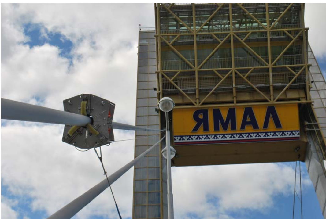
Рисунок 4 - Контроль каната мостового сооружения
